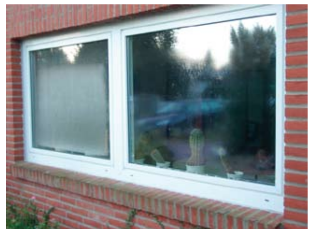
Abbildung 6: Zweiflügeliges Fenster, beide Verglasungen haben den gleichen U_g -Wert, rechts Pilkington Activ™ .
