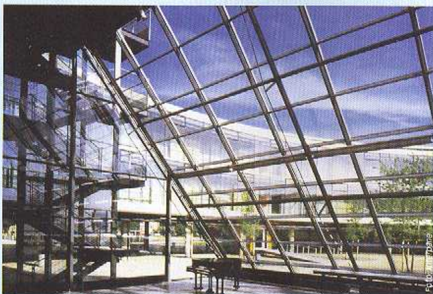
Im öffentlichen Raum müssen Verglasungen besondere Anforderungen an die Verkehrssicherheit erfüllen. Dies gilt insbesondere für Krankenhäuser, Pflegeeinrichtungen, Kindergärten oder Schulen, so auch für das Samuel-von-Pufendorf-Gymnasium im sächsischen Flöha.
